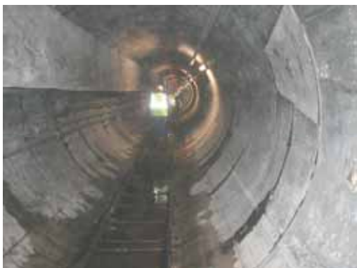
Tunnel de stockage des eaux pluviales
