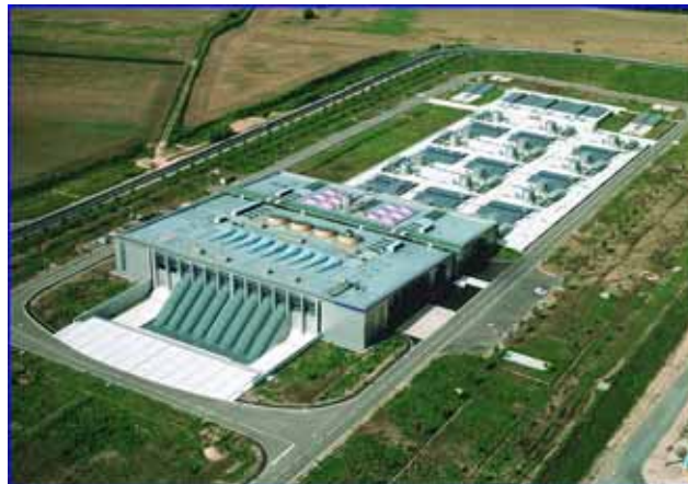
Usine de traitement des eaux de temps de pluie (30 m 3 /s)
