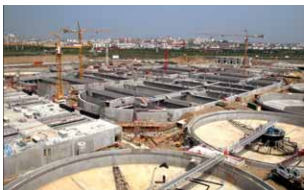
Travaux d'extension de la station d'épuration Seine aval
